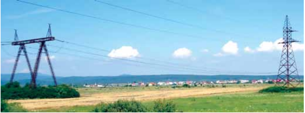
Мал. 62. Високовольтна лінія електропередачі для експорту електричного струму в Мукачівському районі Закарпатської області
