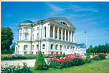
Палац К. Розумовського в м. Батурин на Чернігівщині, пам'ятка класицизму (архітектор Чарльз Камерон, зведено в 1799–1803 рр., відреставровано в 2003–2008 рр.; сучасне фото)
