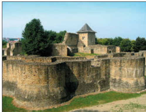
■ Руины княжеского замка 1374 г. в Сучаве. Современный вид
