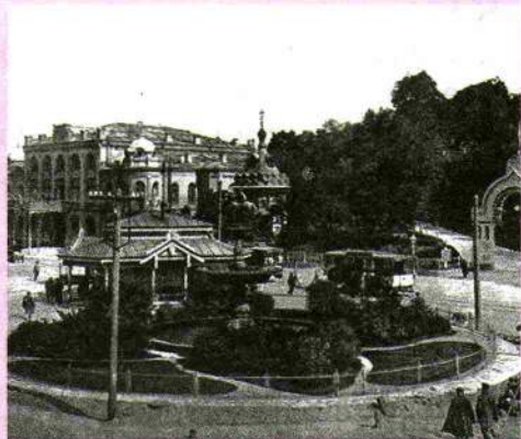
Будинок Купецького зібрання
