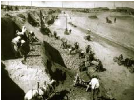
Вивіз землі з котловану на будівництві Дніпровської ГЕС. 1930 р.
